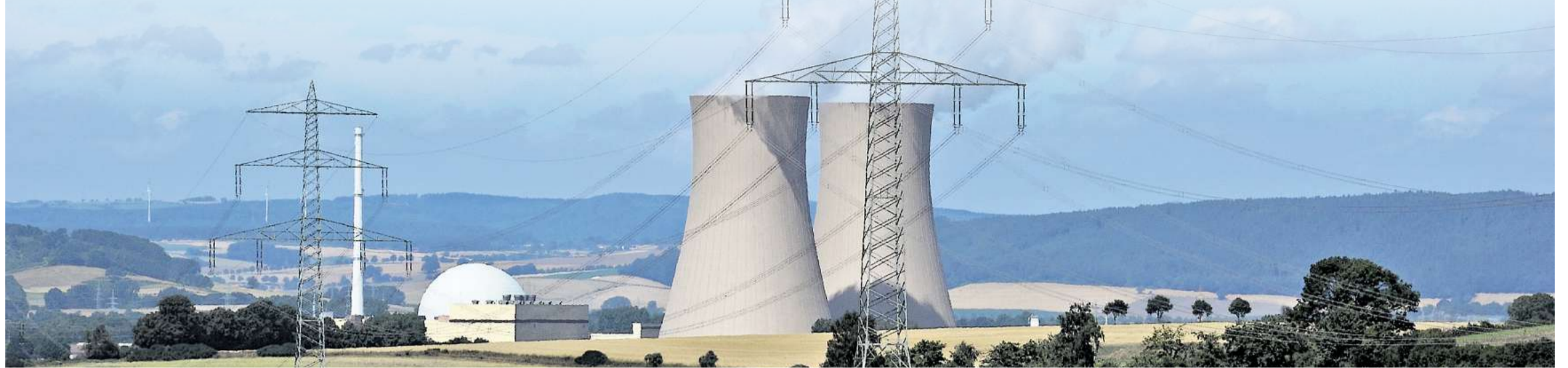
Soll bei Eon bleiben: Das Kernkraftwerk Grohnde läuft voraussichtlich noch bis zum Jahr 2021.
